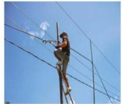
Gambar 8. Pemasangan Kabel Listrik
