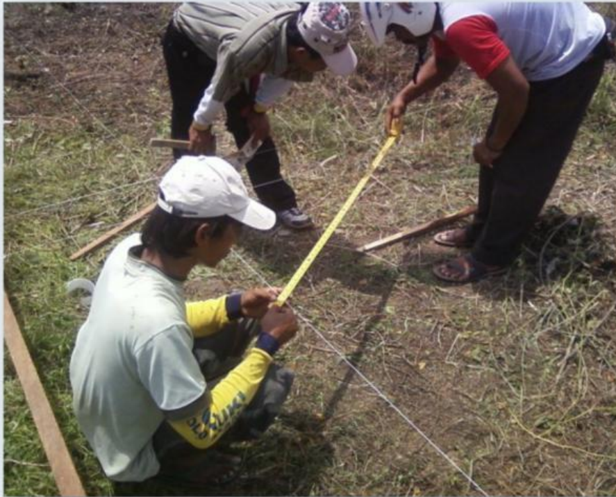
Gambar 1. Seorang tukang sedang mengukur kesikuan lahan
