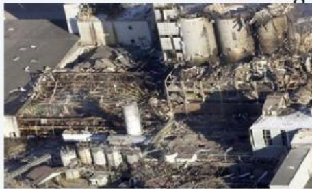
Gambar 5. Akibat ledakan pabrik gula (Sumber : baghouse.com )
