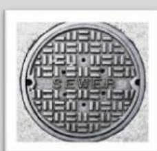
a sewer lid ['sjʊəlɪd]
