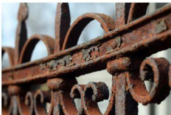
Gambar 1. Perkaratan Pada Pagar Besi
