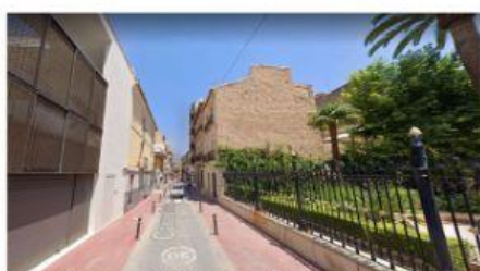
Imatge 1. Reforma d'habitatge unifamiliar (esquerra) situat al centre antic del poble, on predomina l'arquitectura modernista.
