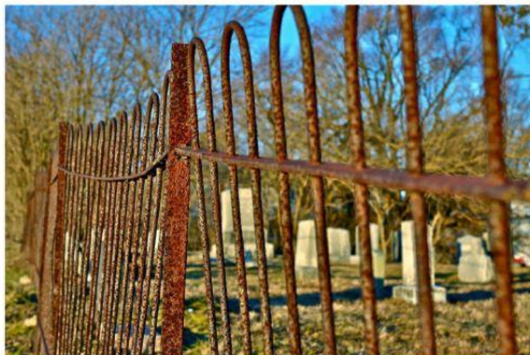
A rusted gate (valla oxidada)
