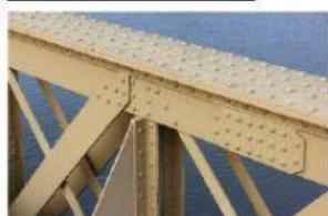
La unión mediante **remaches** se emplea cuando hay que unir piezas de poco espesor, como láminas o chapas.
