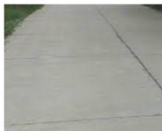
ถนนคอนกรีต
