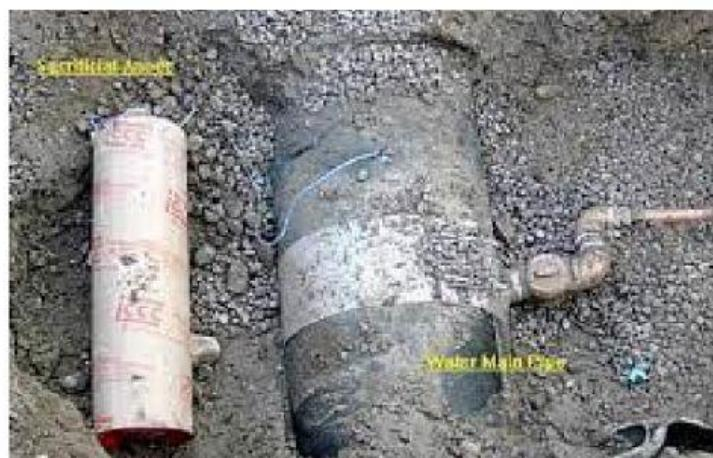
Perbaikan pipa bawah tanah yang terkorosi mungkin memerlukan perbaikan yang mahal biayanya. Hal ini dapat diatasi dengan Teknik sacrificial anode, yaitu dengan cara menanamkan logam magnesium kemudian dihubungkan ke pipa besi melalui sebuah kawat. Logam magnesium itu akan berkarat, sedangkan besi tidak karena magnesium merupakan logam yang aktif (lebih mudah berkarat).
