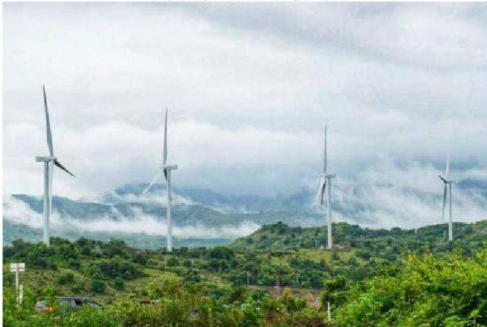
Pembangkit Listrik Tenaga Bayu
