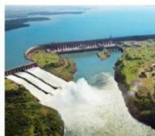
Usina hidrelétrica de Itaipu
