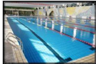
Air kolam kelihatan cetek
