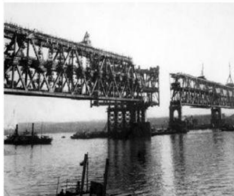
Моста Русе – Гюргево, построен от 1952г. до 1954г. с помощта на СИВ
