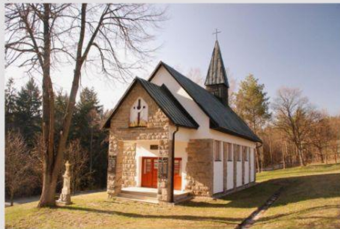
Obrázek 2 Zrekonstruovaná kaple na Ploštině
